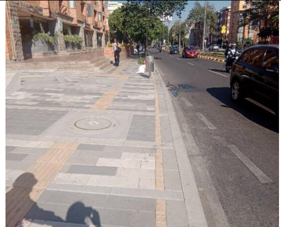
Evidencia del andén sentido oriente occidente de la rotonda sin rampa de acceso ni bahía de parqueo.
