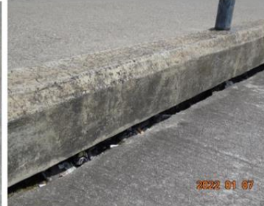
Ilustración 33: Detalle de flexión en las vigas y luz entre bordillo y placa
