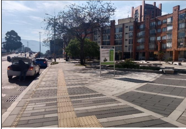
Evidencia del andén sentido occidente oriente de la rotonda sin rampa de acceso ni bahía de parqueo.
