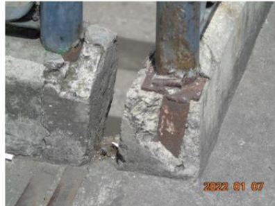
Ilustración 32: Corrosión en anclaje de baranda
