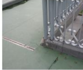
Fisuras y desgaste de material de recubrimiento
