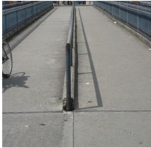
0: Detalle de bordillo y baranda en el medio de la pasarela en luz 1-2 y 2-3
